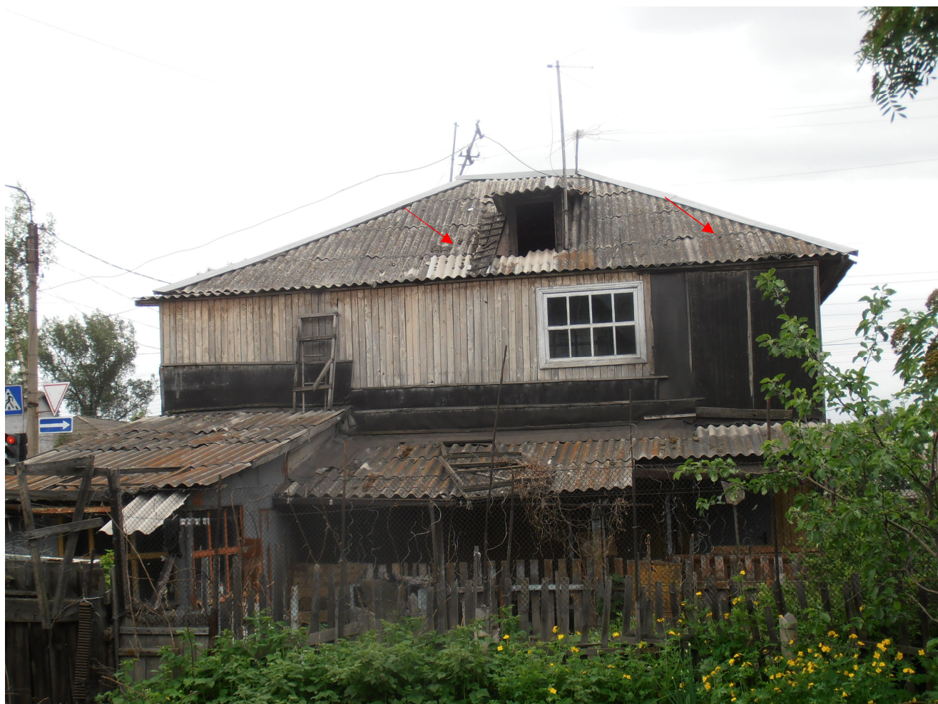
Фото 2. Разрушение кровельного материала – асбестоцементных листов. Вентканалы и фановые трубы не выведены за пределы чердака, отсутствуют ходовые трапы, снегозадержатели
