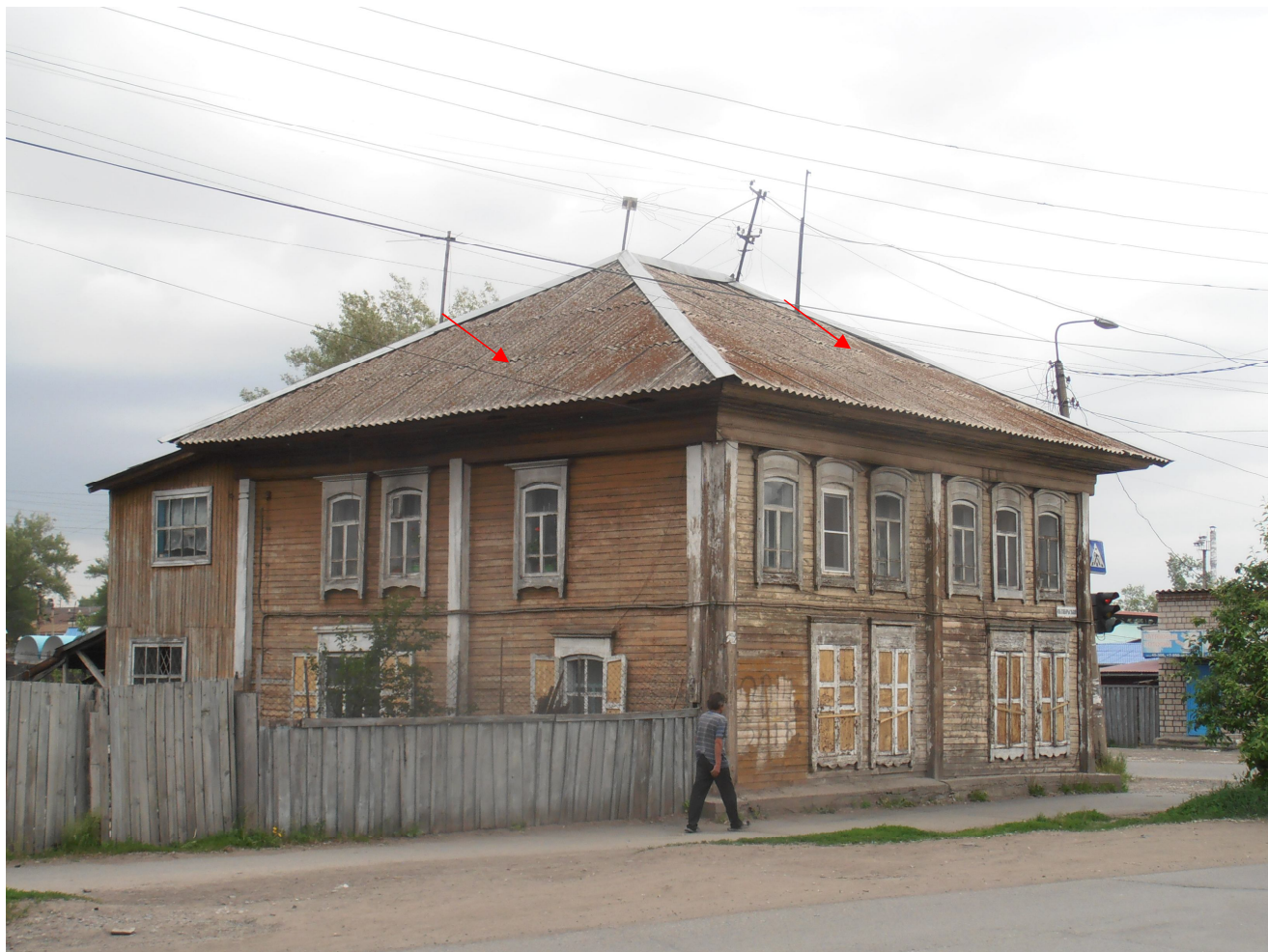
Фото 3. Разрушение кровельного материала – асбестоцементных листов. Вентканалы и фановые трубы не выведены за пределы чердака, отсутствуют ходовые трапы, снегозадержатели
