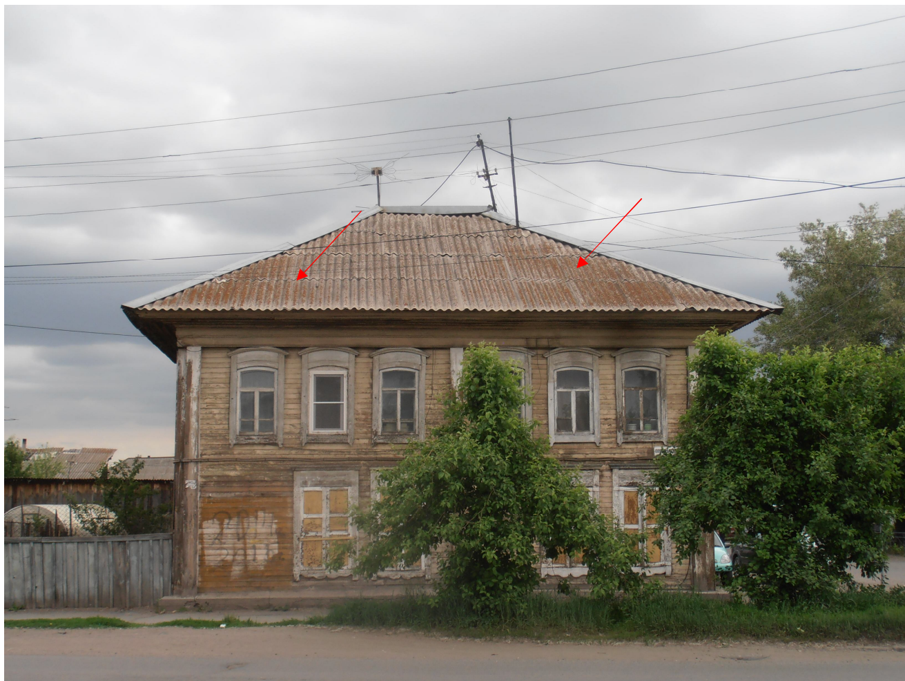
Фото 1. Разрушение кровельного материала – асбестоцементных листов. Вентканалы и фановые трубы не выведены за пределы чердака, отсутствуют ходовые тра- пы, снегозадержатели
